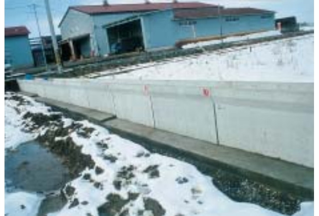
底板部コンクリート完了
