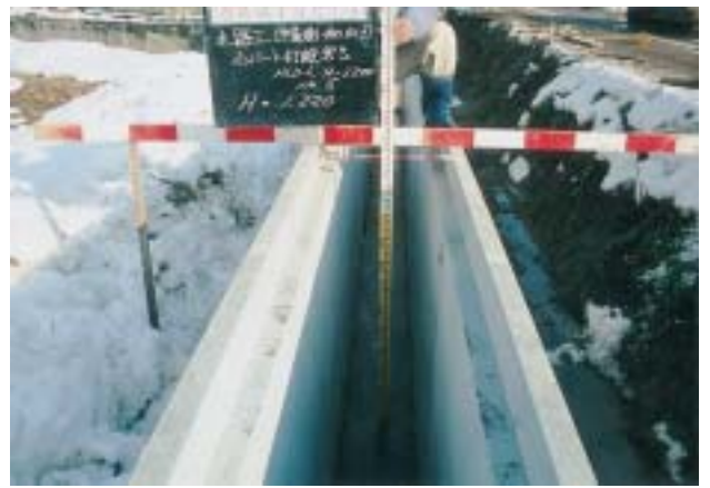
インバートコンクリート打設
