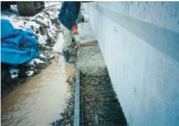
底板部コンクリート打設
